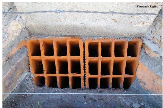
Detalle de la sección del tubo
