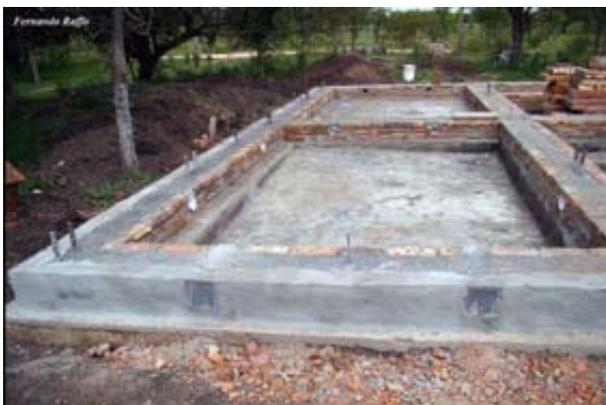
5. Viga de encadenado terminada y aislada
