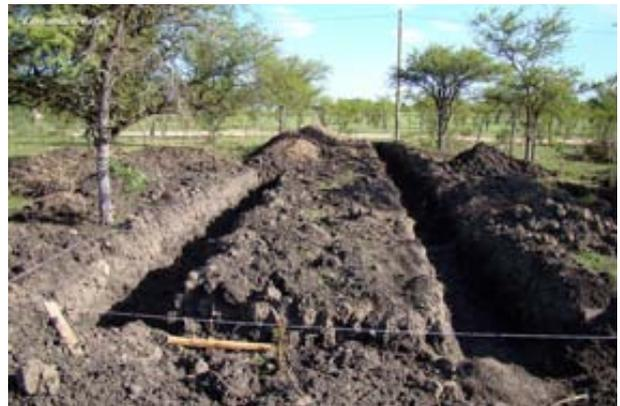
*Excavación de cimientos y replanteo*
