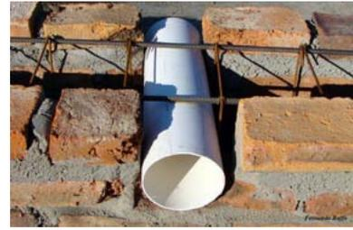
*Ventilación a través de la viga de fundación*
